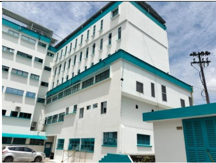
3. Pintura doméstico sobre fachada
