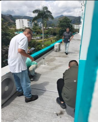
5. Impermeabilización de cubierta
