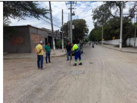
12. Inspección de pozo cercano a institución Jorge Eliécer Gaitán
