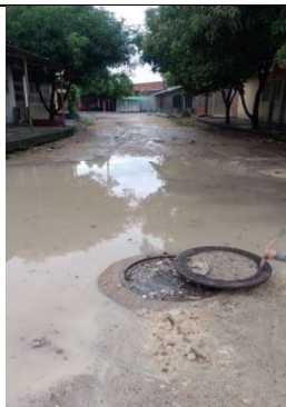
17. Pozo rebosado. Fuente: contratista
