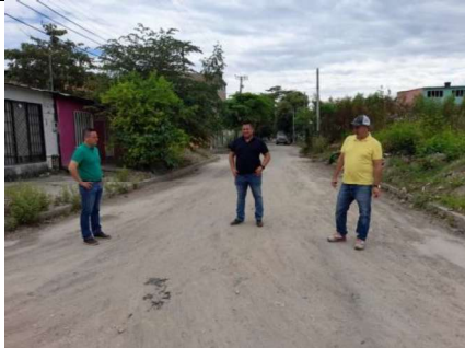
9. Acompañamiento de interventoría, municipio y contratista de obra
