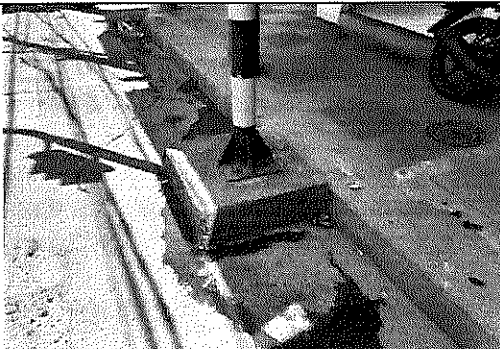
4. Cimentación de semáforos
