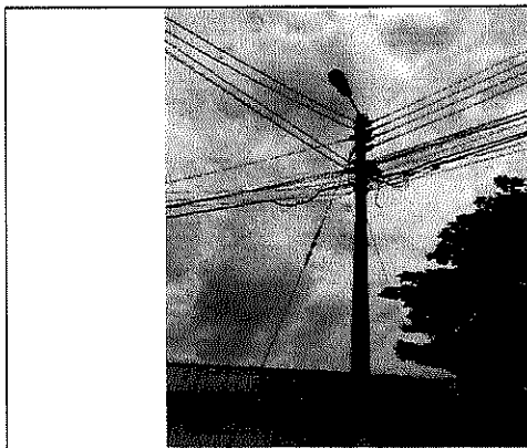
3. Instalaciones en postes
