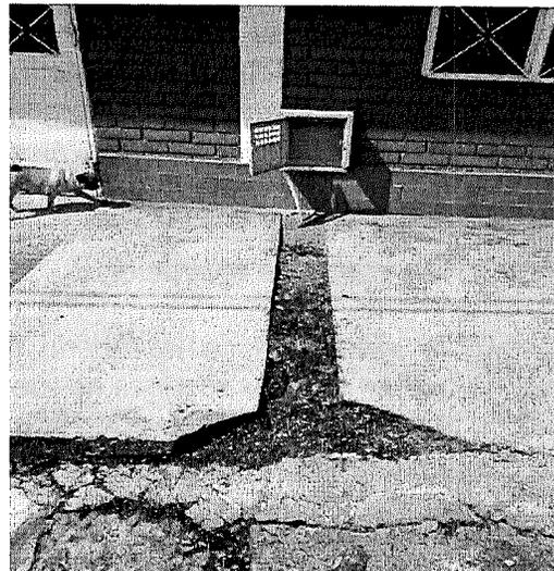
**Fotos:** Cajas mal instaladas en alto deterioro y sin medidor
